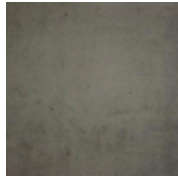
„sichtbeton / fließbeton + sand playa blanca (tolumben) in den nasszellen mit epoxidharz versiegelt
